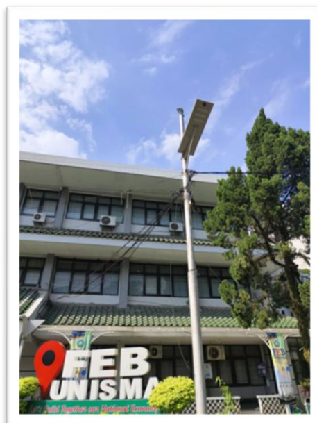
Gambar 28. Lampu penerangan jalan berbasis Solar PV
